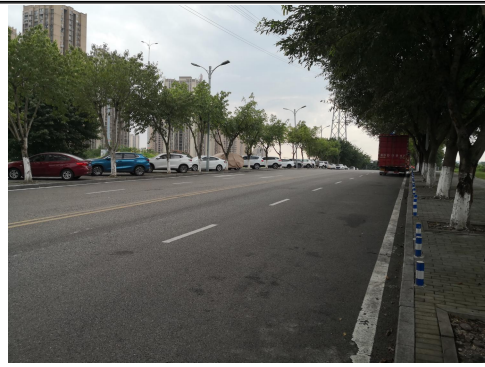
项目南侧道路
