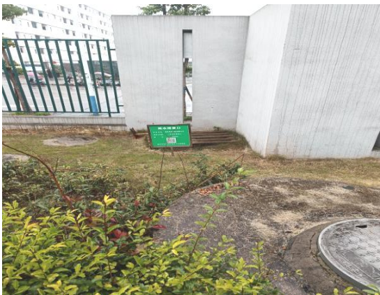
C 区污水排放口
