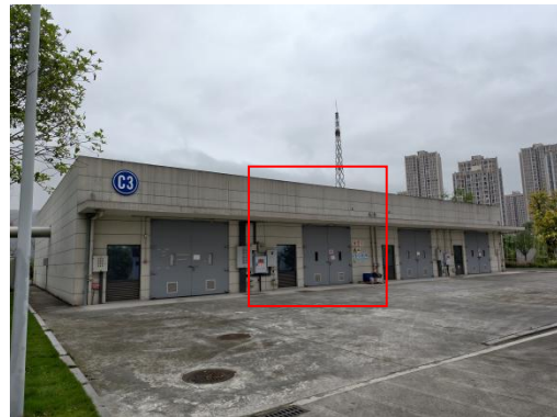
危险废物贮存间
